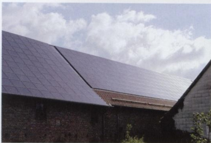
Teilaufnahme SUNpower Roof® 50 kW, amorph
