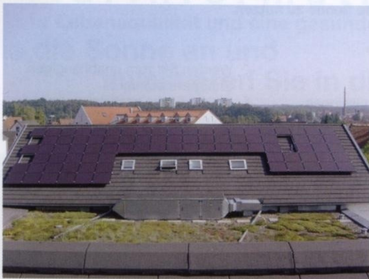
Aufdachanlage 6 kW, amorph
