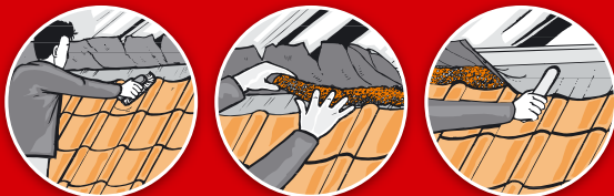
Abdichten von defekten Bleianschlüssen
